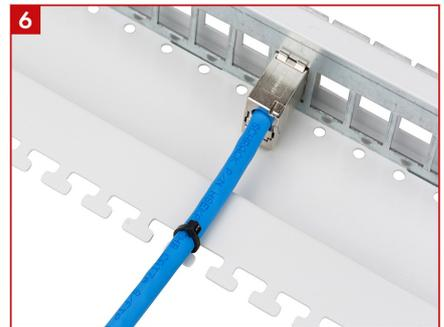
Kabelbinder am Ende mit einem Seitenschneider abtrennen. Bestellnummer HTOOL0002
