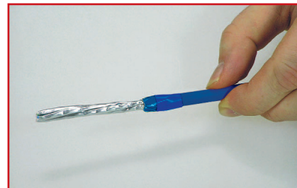
Das Geflecht mit Isolierband oder Kupferfolie fixieren. / Fix the braid by use of a glueing tape or copper foil.
