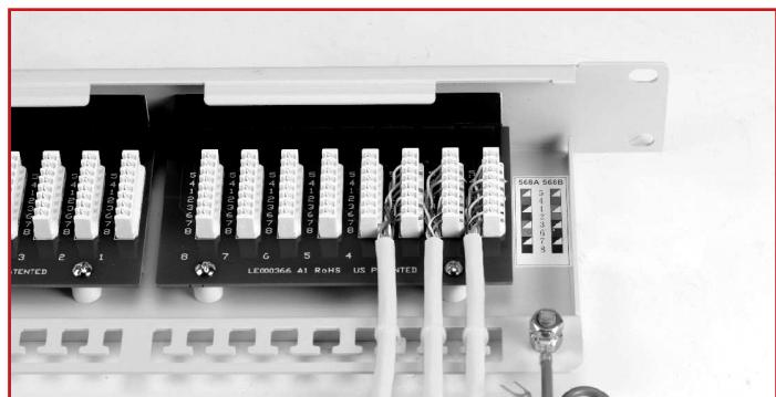
Fixieren Sie das Kabel mit Kabelbindern an der Zugentlastung. Entfernen Sie die Überlängen der Kabelbinder. Befestigen Sie das Panel am gewünschten Platz im Netzwerkschrank. Verbinden Sie den Erdungspunkt bzw. das beige-fügte Erdungskabel mit der Schrankerdung.
