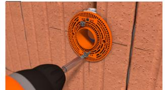
Schrauben finden im Geräteträger eine Öffnung und Halt.
