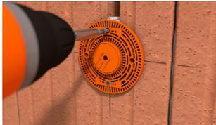
Geräteträger aufstecken und mit 2 Schrauben befestigen.
