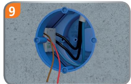
9 **Elektronikdose:** Genügend Platz im Inneren für Elektronikbauteile.
