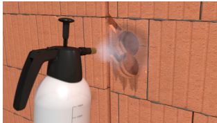
Dosenbohrung leicht anfeuchten, damit Schaum schneller aufquillt.
