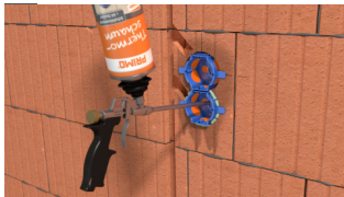
Schaum einsprühen: Wärmebrückenfreie/luftdichte Installation.
