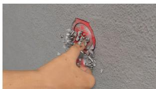
Putzdeckel mit der Hand eindrücken oder mit einer Bohrkronen aufbohren.
