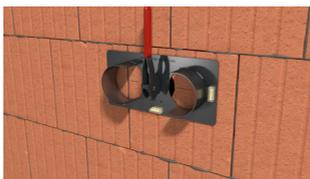
Bohrschablone einsetzen u. ausrichten. Mit Hebel festspannen und weitere Löcher bohren.
