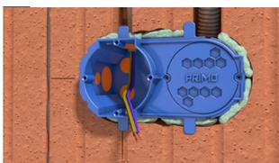
Leitung durch Membran durchstoßen und einführen.
