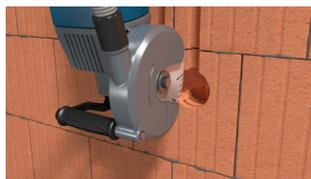
Schlitz bis kurz vor Dosenloch fräsen oder Schlitz bis in das Dosenloch fräsen.
